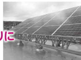
太陽光パネル設置風景
