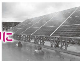
太陽光パネル設置風景
