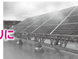
太陽光パネル設置風景
